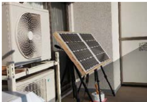
ベランダに設置したパネル
