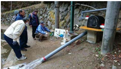
右側奥の黒いのがペルトン型水車発電
